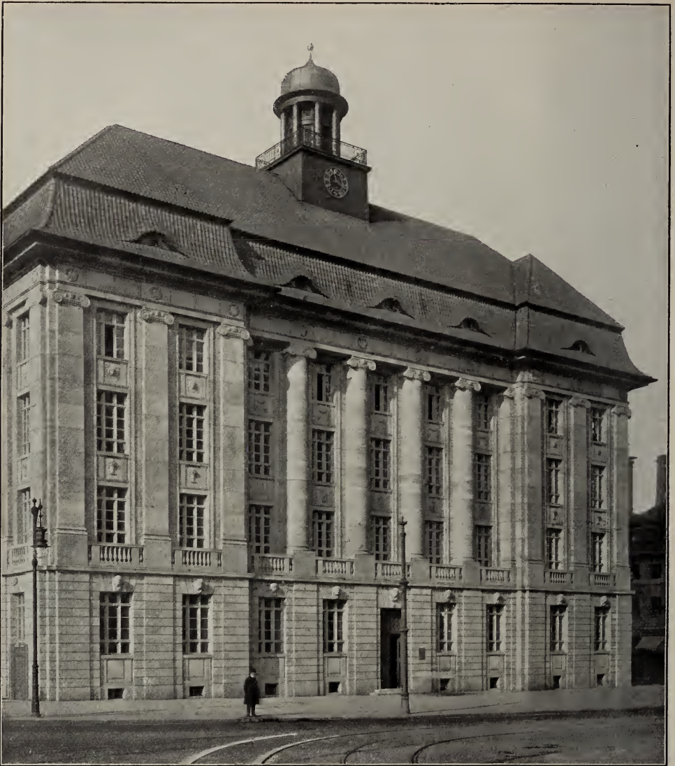
⊠ Hauptfassade des Verwaltungsgebäudes der Berliner Städtischen Gaswerke ⊠
